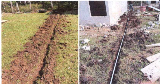
Foto 7: Instalación de tuberías y llaves de chorro.
