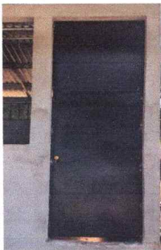
Foto 3: Sustitución de puertas de madera por metal
