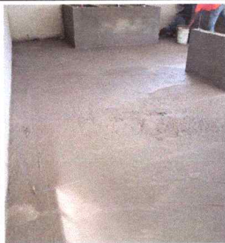
Foto 5 Sustitucion de piso de torta de concreto
