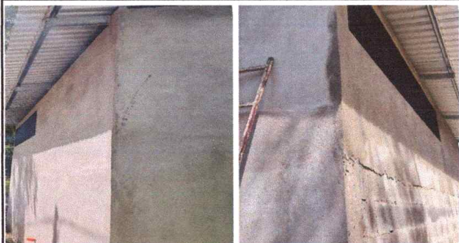
Foto 9: Repello en muro
