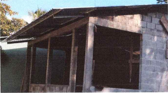
Foto 1: Sustitución de láminas, por lámina troquelada aluzinc, calibre 26
