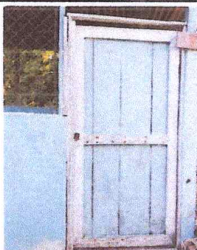
Foto 3: Sustitución de puerta de madera por metal
