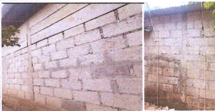
Foto 9: Repello en muro
