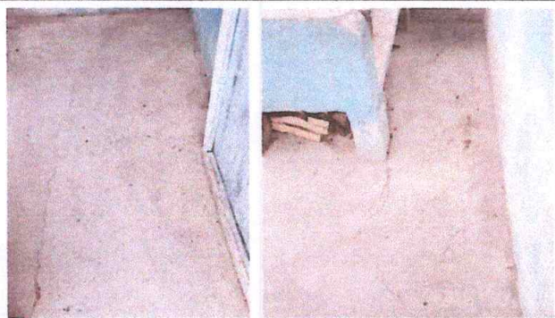
Foto 5 Sustitucion de piso de torta de concreto
