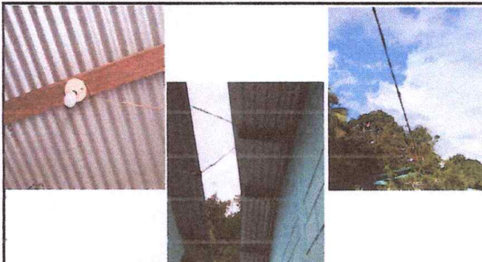
Foto 8: Sustrucion de cables y lámparas.
