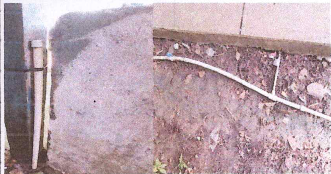
Foto 7: Sustrucion de tuberías y llaves de chorro.
