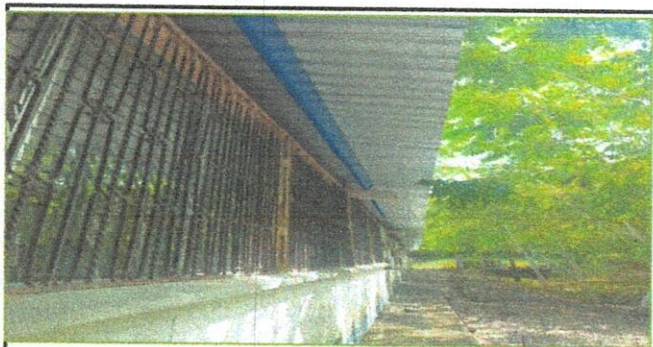
Foto No. 3: Captura de la parte trasera del Ala 1, con la láminas en la fase final del proyecto.
