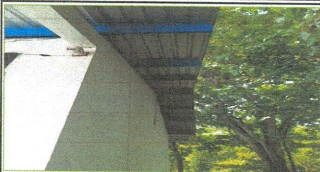
Foto No. 1: Finalización del programa de Mantenimiento de Edificios Escolares Públicos.
