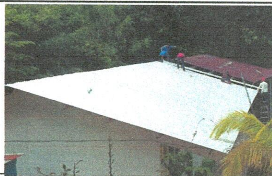
Foto No. 2: Toma aérea de la instalación de laminas.
