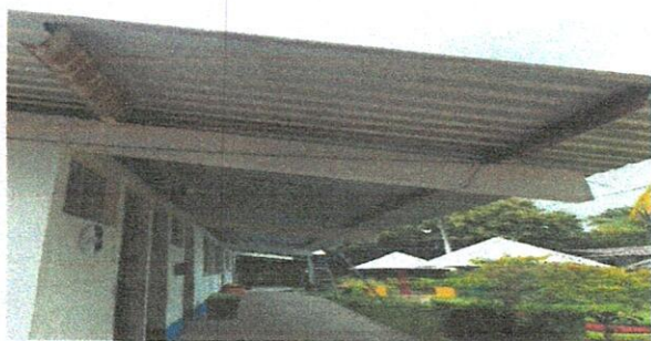
Foto No. 5: Vista por debajo del techo.
