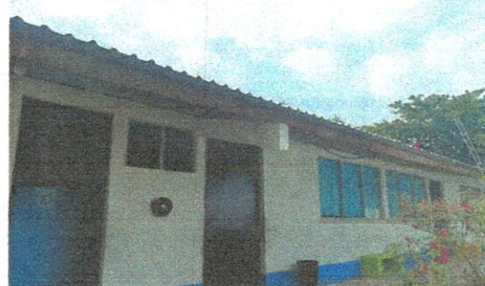
Foto No. 6: Visualización de la Lámina troquelada ya instalada.
