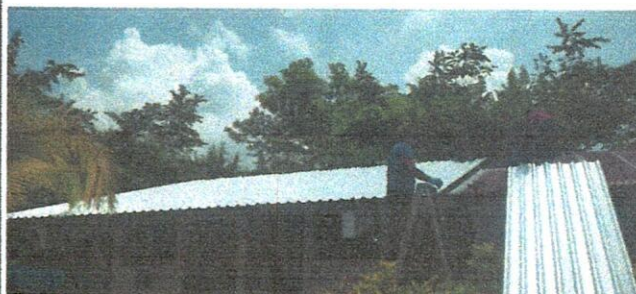
Foto No. 4: Vista lateral de la instalación de laminas.
