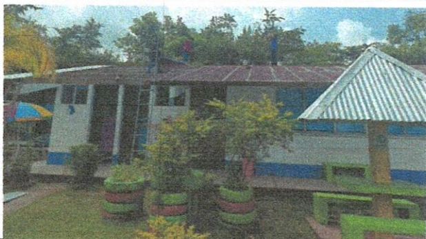
Foto No. 3: Lado lateral de la desistalación de la lámina deteriorada.
