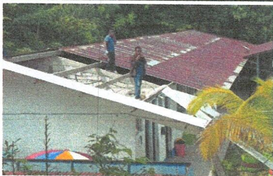
Foto No. 1: Desistalación de Lámina para el inicio del proyecto.
