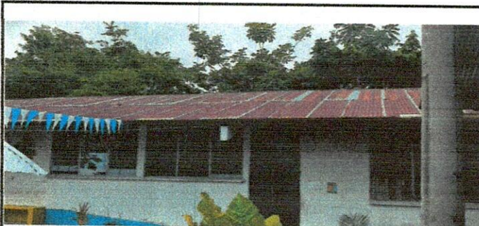
Foto #01: Ala #1, techo colocado desde el año 2002 con deterioro visible, área donde funciona actualmente 4to. 5to. Computación Laboratorio de Biología, de computación #01. Dirección, secretaría, contabilidad y el área de baños.
