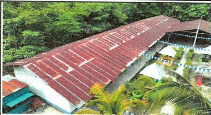
Foto #01: Ala #1, techo colocado desde el año 2002 con deterioro visible, área donde funciona actualmente 4to. 5to. Computación Laboratorio de Biología, de computación #01. Dirección, secretaría, contabilidad y el área de baños.
