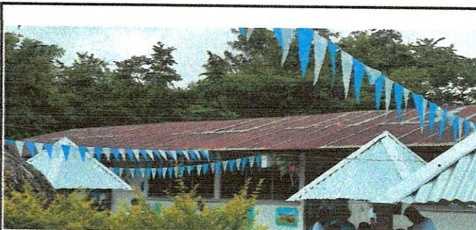
Foto# 04: Vista frontal de norte a sur del aula de 4to. Y 5to. Bach. En Computación ala #01 y área de baños.
