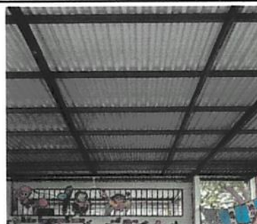
Foto 4: (1.1) Sustrución de lámina, por lámina troquelada aluzinc calibre 26
