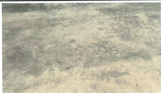
Foto 1: (6.5) Sustrución de piso de torta de concreto
