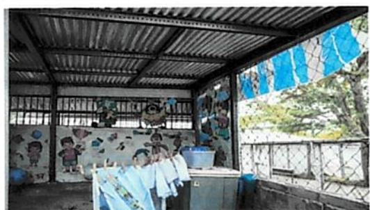
Foto 5: (2.2) Sustrución de estructura de soporte de madera, por metal
