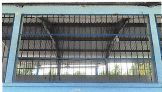
Foto 3: (5.6) Sustrución de balcones de metal
