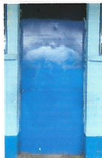
Foto 2: (4.4) Sustrución de puerta en servicios sanitarios
