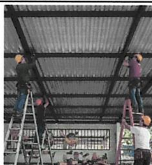
Foto: 4 (1.1) Sustitución de lámina, por lámina troquelada aluzinc calibre 26
