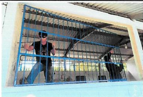
Foto: 3 (5.6) Sustitución de balcones de metal
