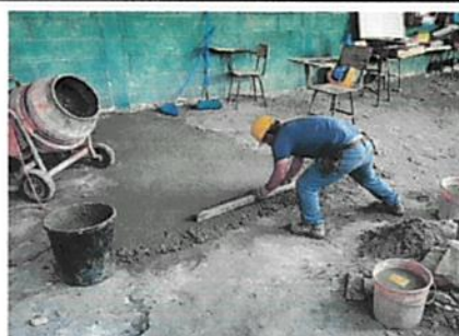
Foto: 6 (6.5) Sustitución de piso de torta de concreto
