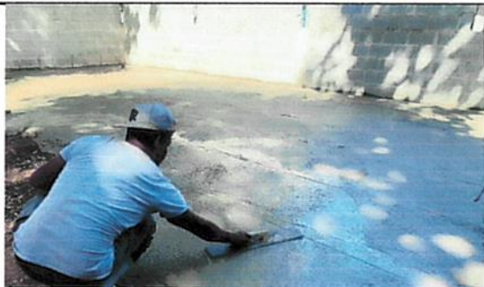
Foto 1: (6.5) Sustitución de piso de torta de concreto
