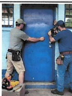
Foto 2 (4.4) Sustitución de puerta en servicios sanitarios
