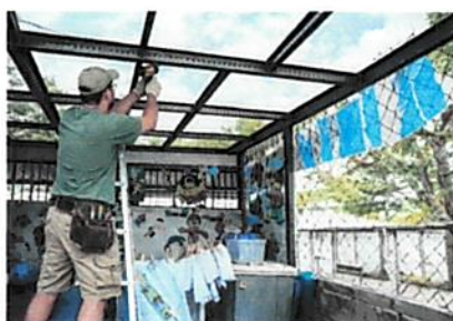
Foto: 5 (2.2) Sustitución de estructura de soporte de madera, por metal
