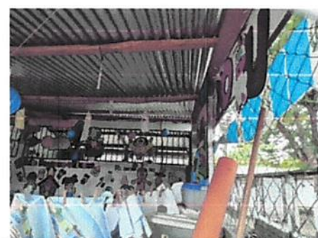
Foto: 5 (2.2) Sustitución de estructura de soporte de madera, por metal
