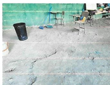
Foto: 6 (6.5) Sustitución de piso de torta de concreto
