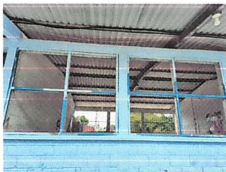
Foto: 3 (5.6) Sustitución de balcones de metal
