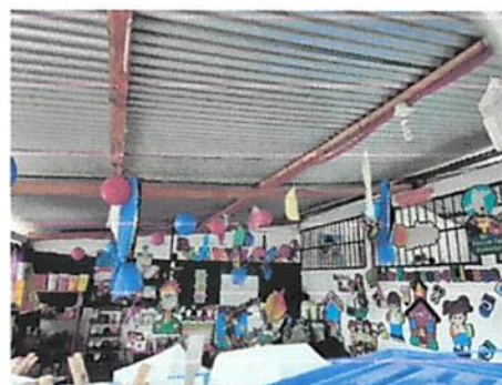
Foto: 4 (1.1) Sustitución de lámina, por lámina troquelada aluzinc calibre 26
