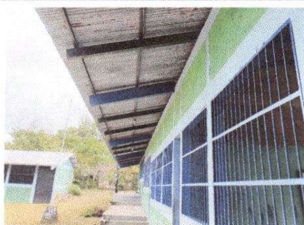
Foto 3: Mantenimiento a balcones de metal
