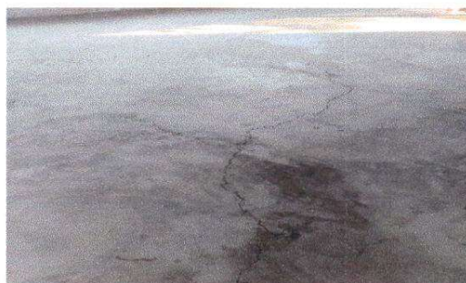
Foto 5: Reparación de piso de torta de concreto
