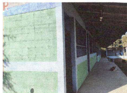
Foto 6: Pintura en muros exteriores e interiores
