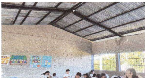
Foto1: Pintura en muros exteriores e interiores
