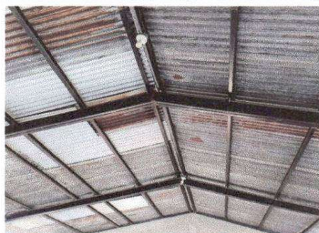
Foto 3: Sustitución de elementos de fijación
