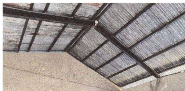
Foto 4: Mantenimiento a estructura de soporte de metal
