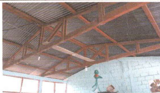
Foto 4: sustitucion de estructura de soporte de madera por metal
