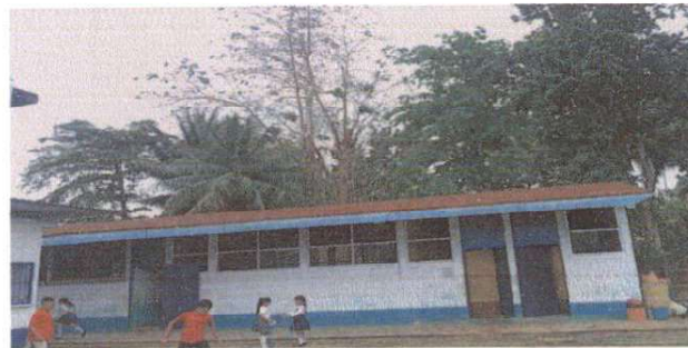
Foto 2: sustitucion de capote de lamina, por lamina troquelada
