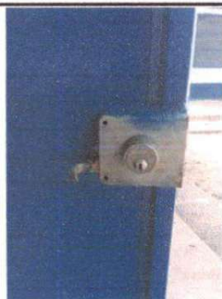
Foto 4: Sustitucion de chapa
