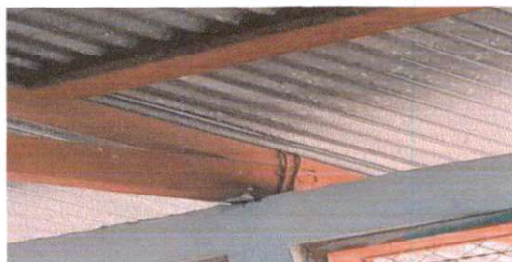
Foto 3: sustitucion de elementos de fijacion
