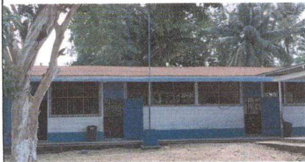
Foto1: sustitucion de lámina, por lámina troquelada alucin calibre 26
