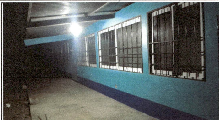
Foto1: Sustitución de ventanas de madera y malla por PVC mas vidrio
