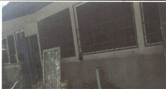
FOTO 1: Sustrucción de ventanas de madera y malla por PVC mas vidrio
