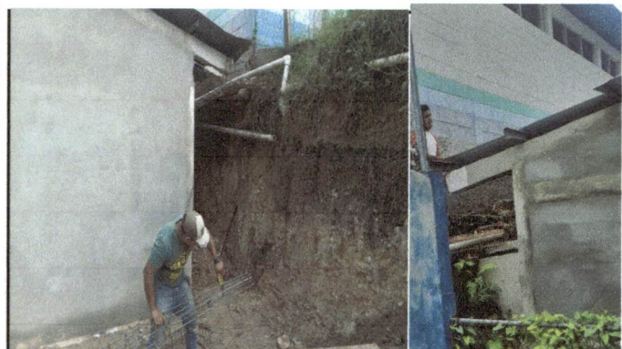
Foto 3: Reparación de banqueta de concreto
