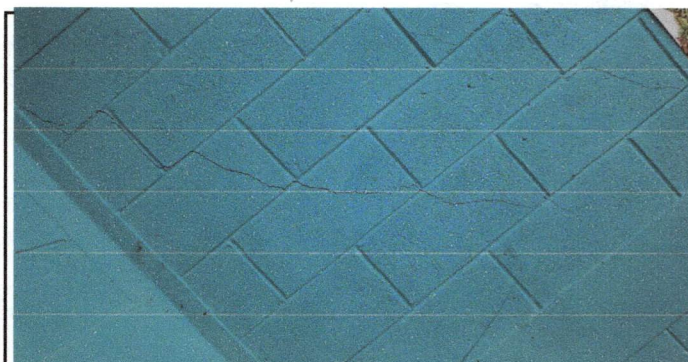
Foto 6: Sellado de grietas y fisuras en muros
