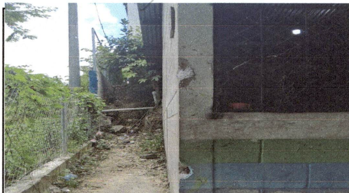
Foto 4: Repello en muro
