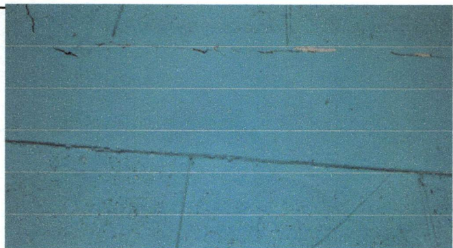
Foto 5: Repello en muro
