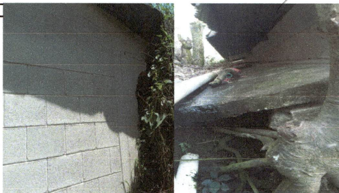
Foto 3: Reparación de banqueta de concreto
