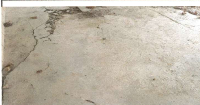
Foto 2: Reparación de piso de cemento líquido.
