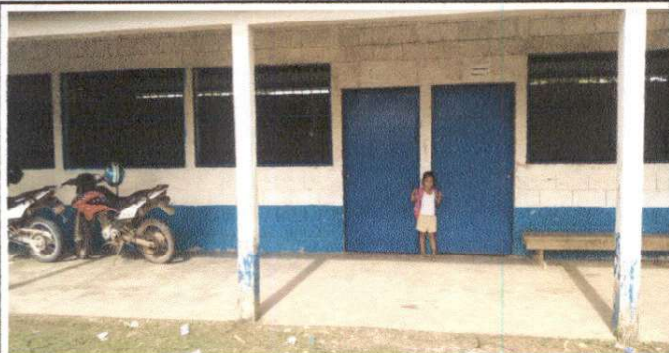
Foto1: Pintura de muros exteriores e interiores
