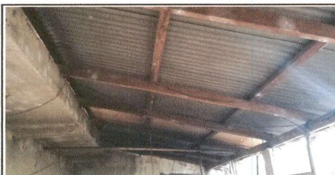
Foto 5: troquelada, // Sustitución de estructura de soporte de madera por metal
