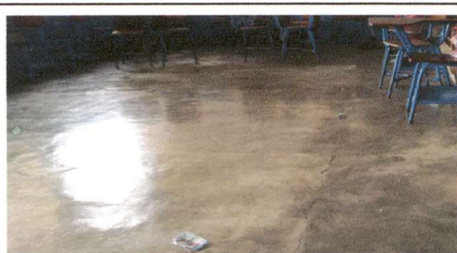
Foto 4: Reparación de piso de cemento líquido.
