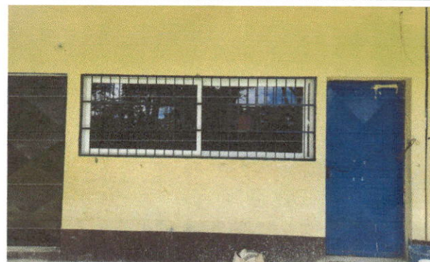
Foto 4: Sustitución de ventanas de madera por metal mas vidrio
