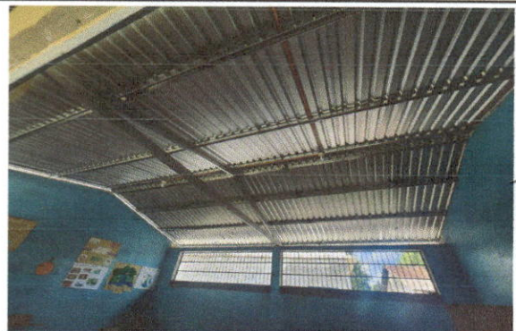
Foto 2: Sustitución de estructura soporte de madera por metal.
