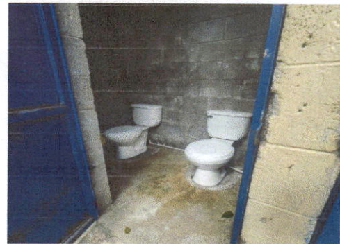
Foto 6: Sustitución de Inodoro
