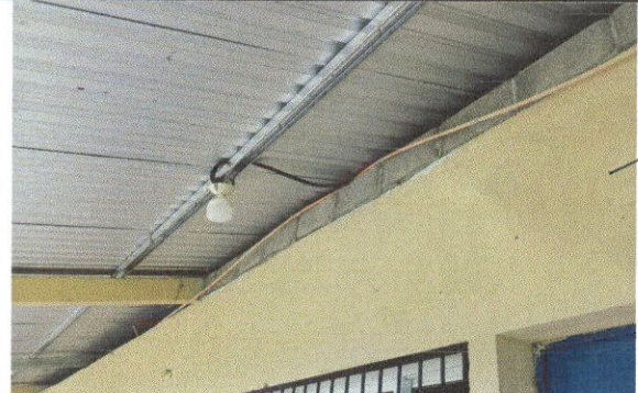
Foto 8: Reparación de cableado eléctrico
