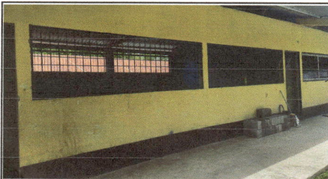
Foto 5: Sustitución de balcones de metal
