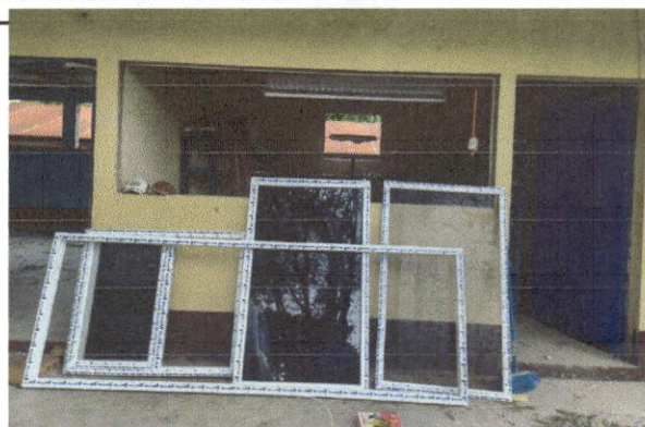
Foto 4: Sustrucción de ventanas de madera por metal mas vidrio
