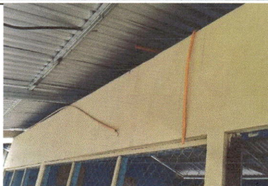
Foto 8: Reparación de cableado eléctrico
