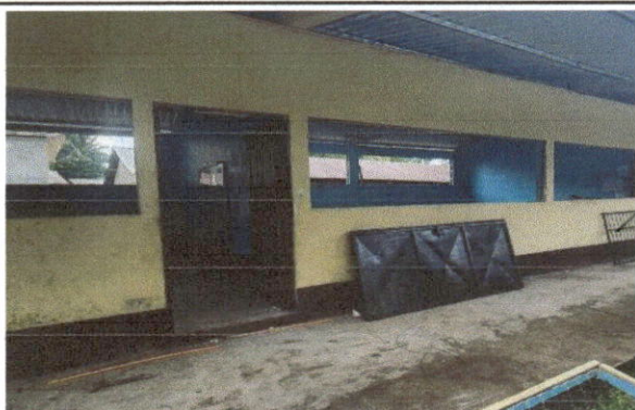
Foto 3: Sustrucción de puertas
