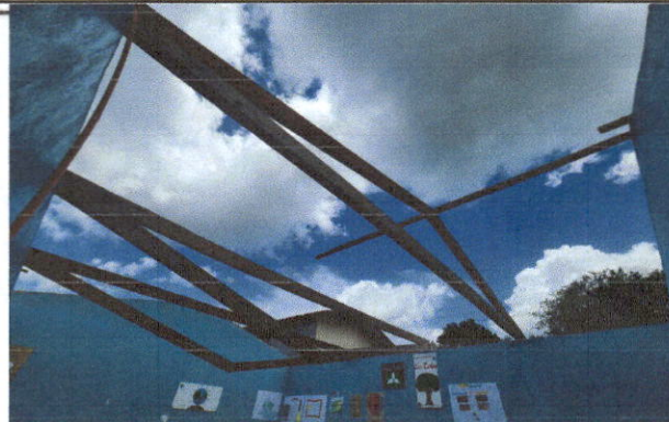
Foto 2: Sustrucción de estructura soporte de madera por metal.
