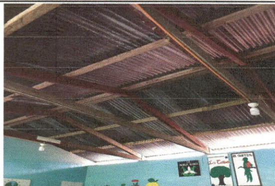
Foto 2: Sustitución de estructura soporte de madera por metal.
