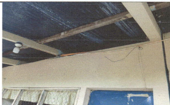
Foto 8: Reparación de cableado eléctrico
