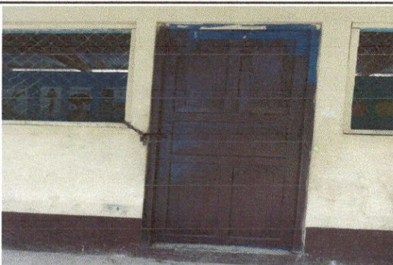
Foto 3: Sustitución de puertas
