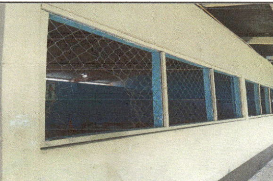
Foto 5: Sustitución de balcones de metal
