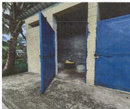
Foto 6: Sustitución de Inodoro
