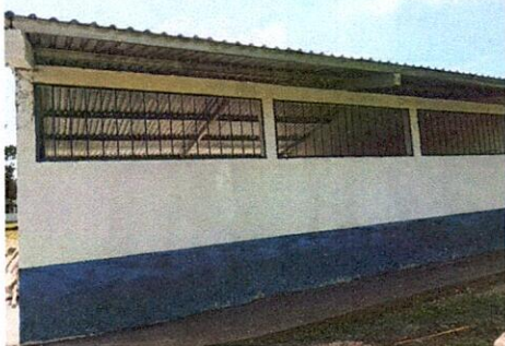
Foto: Parte de atrás de la construcción finalizada
