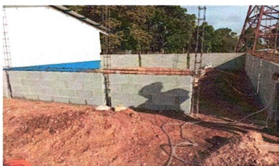
Foto: 3 Levantamiento de block
