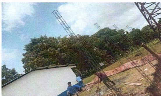
Foto 1: Inicio de la construcción
