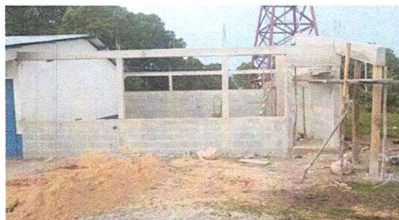
Foto: 6 Levantado final de la obra para el techo
