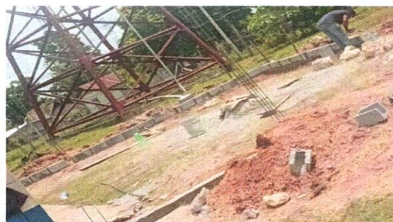
Foto: Fundición de solera
