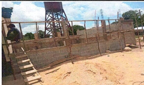
Foto.4 Seguimiento de la construcción
