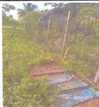
Foto 5: Reparación de Tubo HG y Malla galvanizada
