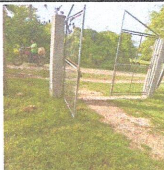
Foto: Reparación de muro perimetral
