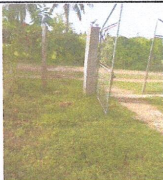
Foto 1: Reparación de muro perimetral
