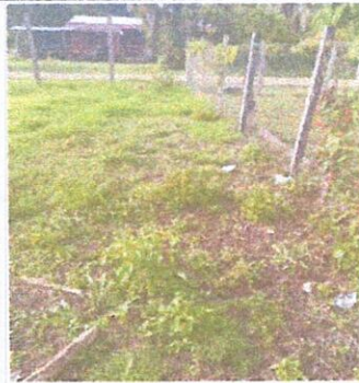
Foto: Reparación de Tubo HG y Malla galvanizada
