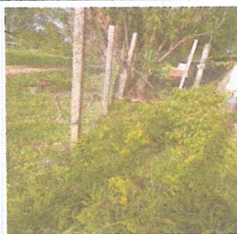
Foto 6: Reparación de Tubo HG y Malla galvanizada
