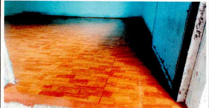
Foto 2: Mejoramiento de piso de cemento líquido a piso cerámico
