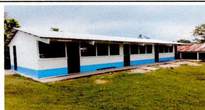
Foto 5: Pintura en muros exteriores e interiores
