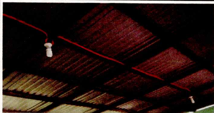
Foto 7: Reparación de cableado eléctrico
