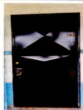
Foto 4: Sustitución de puertas de metal por metal
