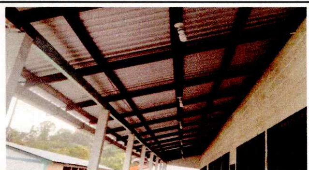
Foto 6: Sustitución de Focos ahorradores
