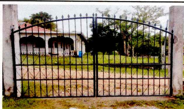
Foto 8: Sustitución de porton de metal
