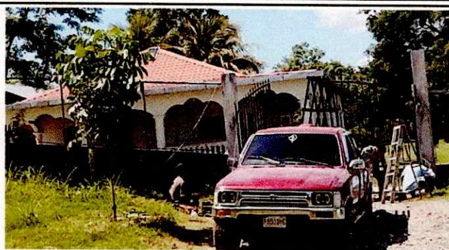
Foto 8: Sustitución de porton de metal
