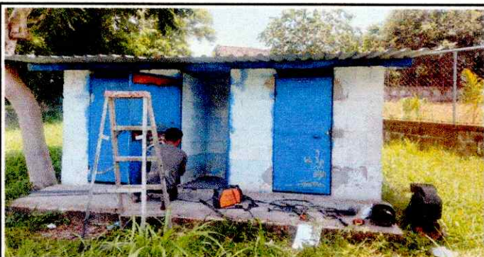
Foto 3: Mantenimiento a estructura (lijado, cambio de tubo, cepillado, sujeciones, aplicación de pintura) a puertas servicios sanitarios
