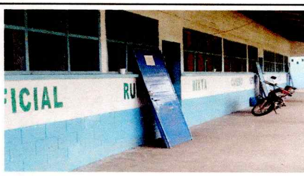
Foto 4: Sustitución de puertas de metal por metal
