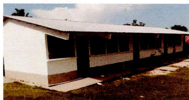
Foto 5: Pintura en muros exteriores e interiores
