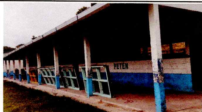
Foto 1: Mejoramiento de balcones de madera y malla metálica por metal
