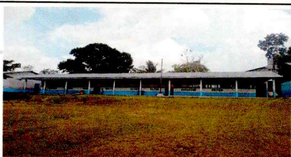
Foto 5: Pintura en muros exteriores e interiores
