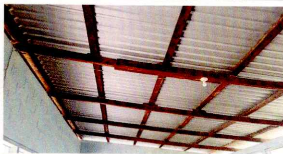
Foto 6: Sustitución de Focos ahorradores
