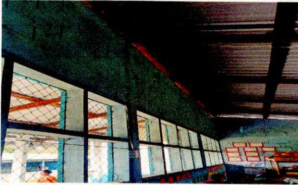
Foto 7: Reparación de cableado eléctrico
