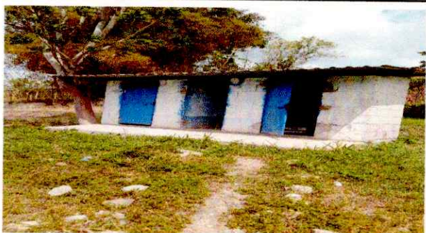
Foto 3: Mantenimiento a estructura (Iljado, cambio de tubo, cepillado, sujeciones, aplicación de pintura) a puertas servicios sanitarios
