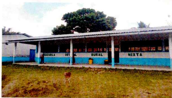
Foto 1: Mejoramiento de balcones de madera y malla metálica por metal
