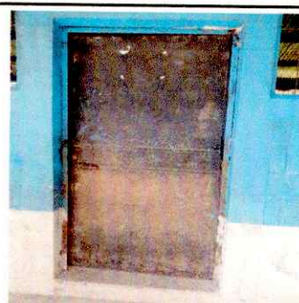
Foto 4: Sustitución de puertas de metal por metal
