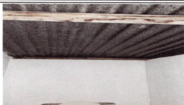
cambio en baño metal por madera
