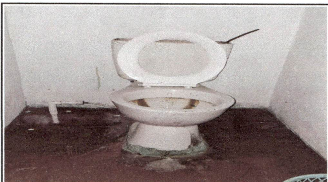
cambio de inodoros en mal estado
