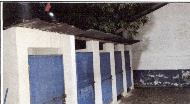
Cambio de techo en baños
