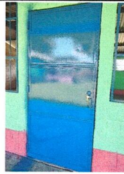
Foto 2: Mantenimiento de estructura y sustitución de chapa.
