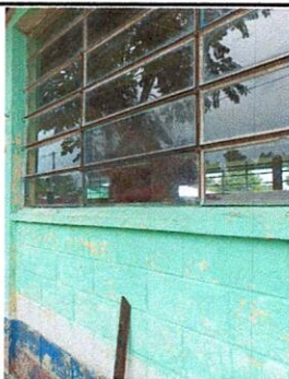
Foto 5: Sustitución de vidrios
