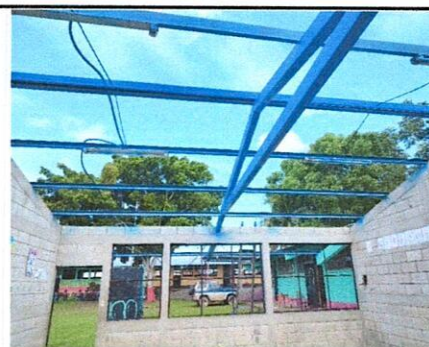
Foto 6: Mantenimiento a estructura de metal (techo)
