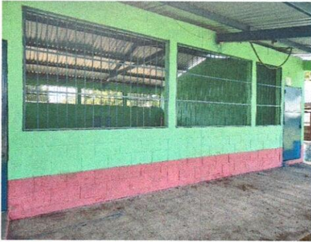
Foto 1: Fabricación e instalación de ventana-balcon de metal
