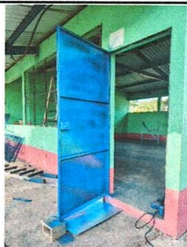
Foto 2: Mantenimiento de estructura y sustitución de chapa.
