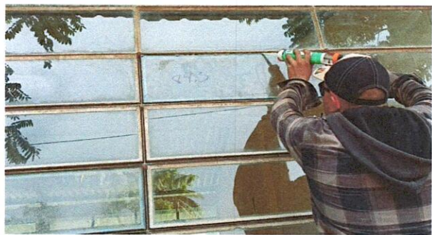
Foto 5: Sustitución de vidrios
