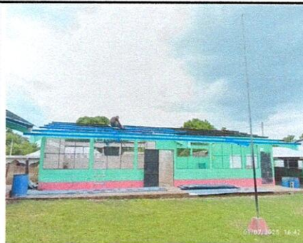
Foto 6: Mantenimiento a estructura de metal (techo)
