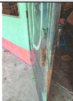
Foto 2: Mantenimiento de estructura y sustitución de chapa.
