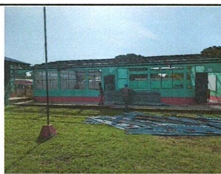
Foto 6: Mantenimiento a estructura de metal (techo)
