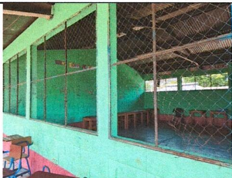
Foto 1: Fabricación e instalación de ventana-balcon de metal
