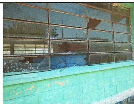
Foto 5: Sustitución de vidrios
