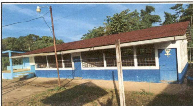
Foto 3: Sustrucción de puerta
