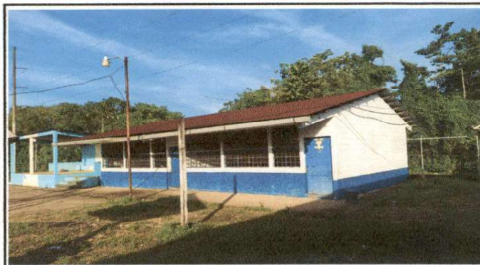
Foto 4: Mantenimiento a estructura de metal de ventana
