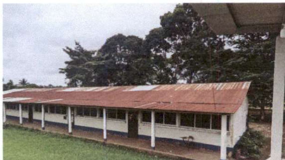
Foto 1: Sustitucion de lamina, por lamina troquelada aluzinc cal 26 legitima
