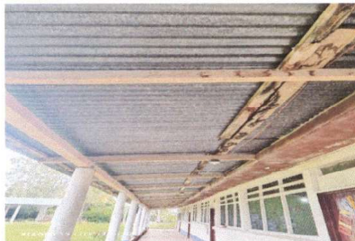
Foto 2: Sustitucion de estructura de madera, por estructura de metal
