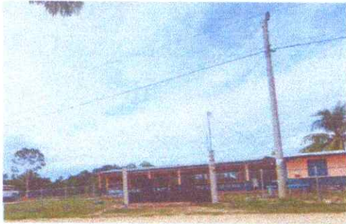
Foto 1: Finalización de tubos HG
