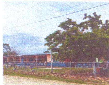
Foto 2: Finalización de tubos HG
