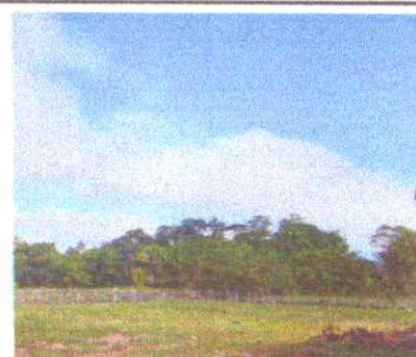
Foto 6: Finalización de tubos HG
