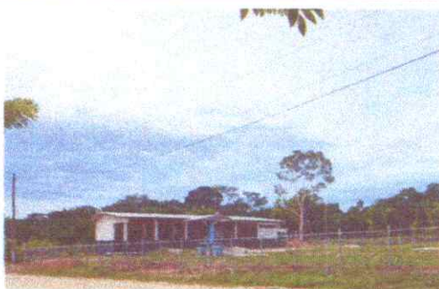
Foto 3: Finalización de tubos HG
