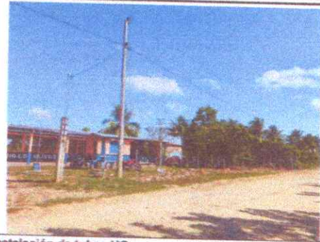
Foto 2: Instalación de tubos HG
