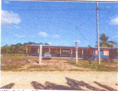
Foto 1: Instalación de tubos HG
