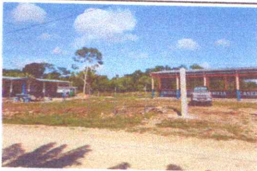
Foto 3: Instalación de tubos HG
