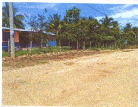
Foto 2: Reparación por tubos HG
