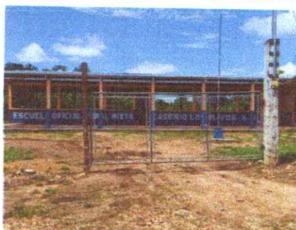
Foto 4: Sustitución de portón por portón de lámina galvanizada
