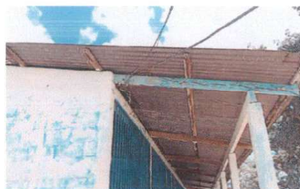
Foto 6: Reparacion de cable electrico
