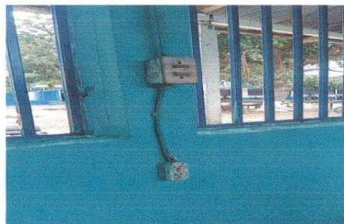
Foto 4: sustitución de tomacorrientes dobles
