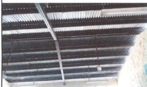
Foto 5: Mantenimiento a estructura de metal
