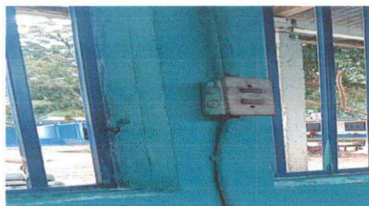
Foto 5: sustitucion de interruptore dobles
