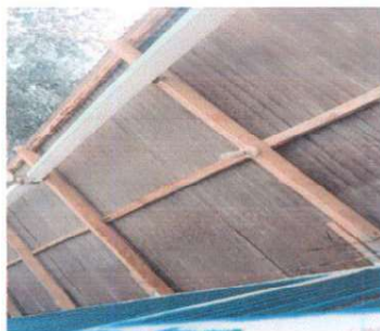
Foto 3: sustitucion de plafoneras
