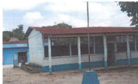
Foto 2: sustrucion de capote de lámina por lámina troquelada
