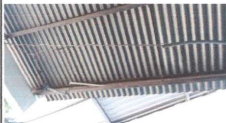
Foto 4: sustrucion de elementos de fijación
