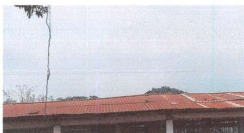
Foto 3: sustrucion de capote de lámina por lámina troquelada
