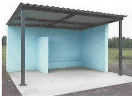
Foto 3: SUSTITUCION DE LAMINA TROQUELADA
