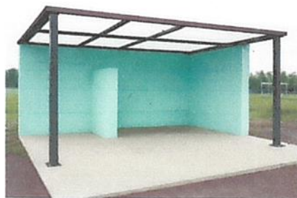
Foto 2: SUSTITUCION DE ESTRUCTURA PORTANTE
