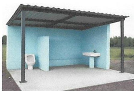
Foto 5: SUSTITUCION DE MIGITORIO Y LAVAMANOS
