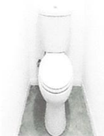
Foto 6: SUSTITUCION DE INIDORO
