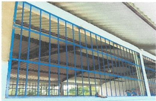
Foto 1: SUSTITUCION DE BALCON DE METAL
