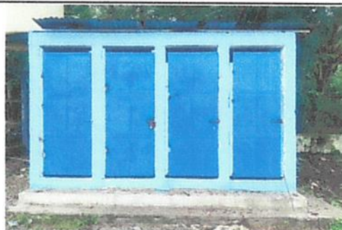
Foto 4: SUSTITUCION DE PUERTAS DE BAÑOS
