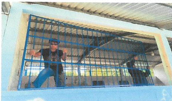
Foto 1: SUSTITUCION DE BALCON DE METAL
