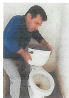
Foto: 6 SUSTITUCION DE INIDORO
