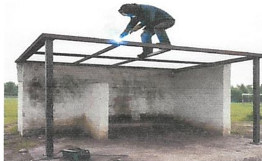
Foto: 2 SUSTITUCION DE ESTRUCTURA PORTANTE
