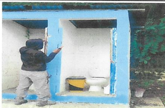
Foto: 4 SUSTITUCION DE PUERTAS DE BAÑOS
