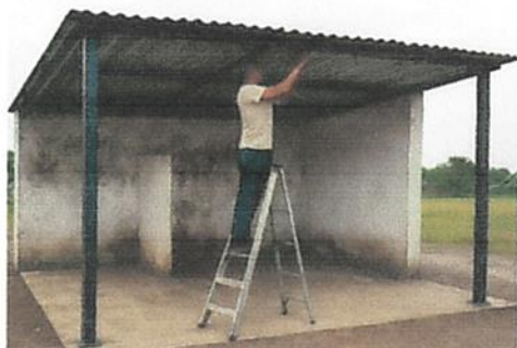
Foto: 3 SUSTITUCION DE LAMINA TROQUELADA
