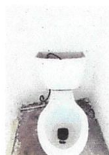
Foto: 6 SUSTITUCION DE INIDORO
