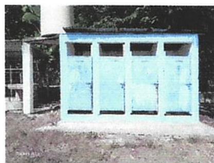
Foto: 4 SUSTITUCION DE PUERTAS DE BAÑOS
