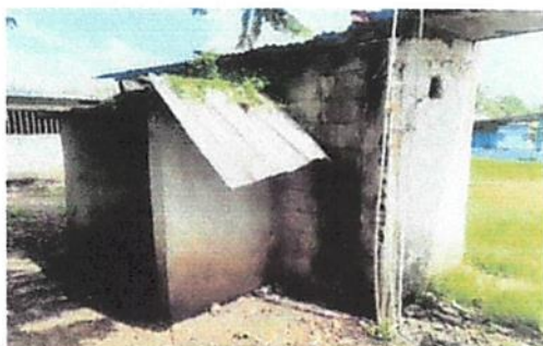
Foto: 3 SUSTITUCION DE LAMINA TROQUELADA
