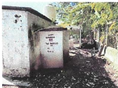
Foto: 5 SUSTITUCION DE MIGITORIO Y LAVAMANOS
