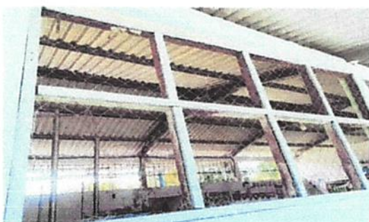
Foto 1: SUSTITUCION DE BALCON DE METAL
