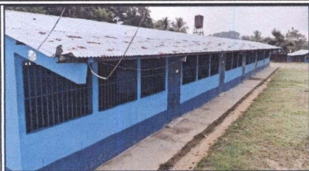
SUSTITUCION DE LÁMINA, POR LAMINA TROQUELADA ALUZINC CALIBRE 26
