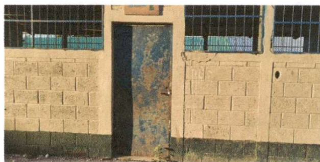
Foto 6: Pintura en muros exteriores e interiores
