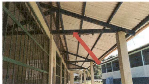
Foto 4: Mantenimiento a estructura de soporte de metal
