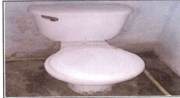
Foto 6: Sustitución de inodoro
