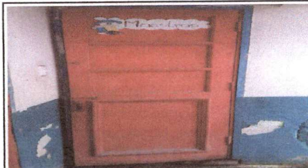
Foto 4: Sustitución de puerta
