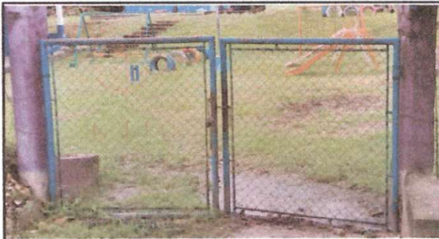
Foto 8: Sustitución de porton de metal
