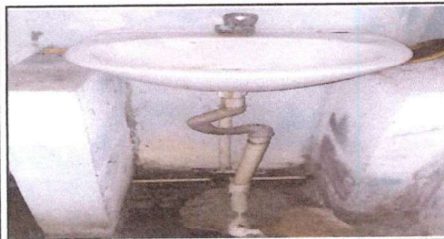
Foto 5: Sustitución de lavamanos
