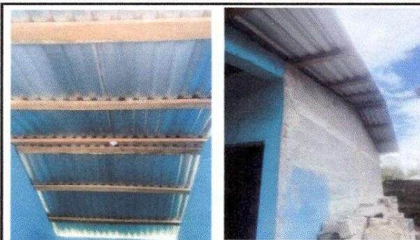
Foto 2: Sustitución de lamina, por lamina troquelada aluzinc calibre 26
