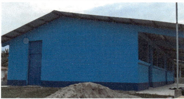
Foto 5: Pintura en muros exteriores e interiores
