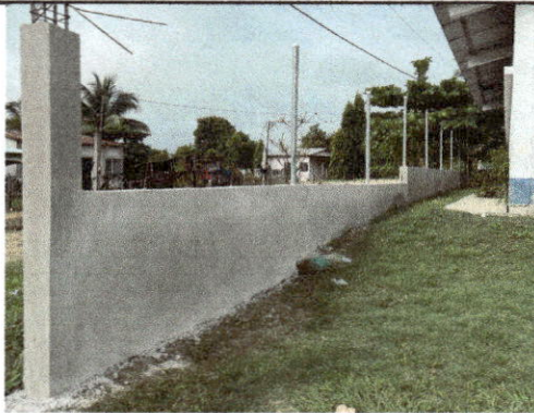
Foto 3: Repello en Muro
