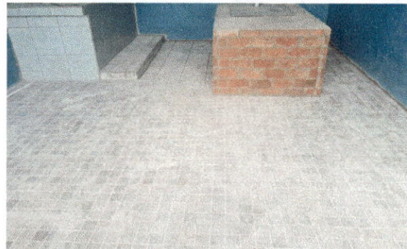
Foto 6: Reparación de piso cerámico
