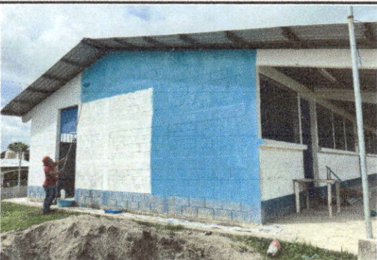
Foto: 5 Pintura en muros exteriores e interiores
