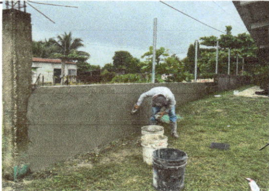
Foto: 3 Repello en Muro
