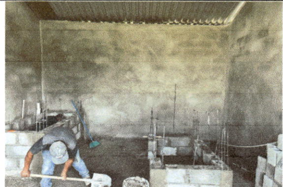
Foto 2: Reparación de Cocina: Sustitución de estufa rural (completa) y Sustitución de pila de cemento de dos lavaderos.
