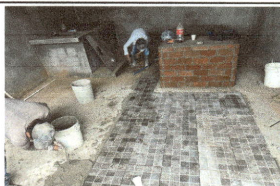
Foto: 6 Reparación de piso cerámico
