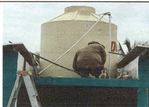
Foto: 4 Sustitución de deposito de agua 1700 lt
