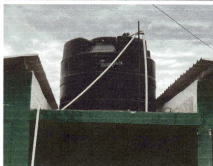
Foto: 4 Sustitución de deposito de agua 1700 lt
