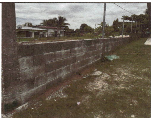
Foto: 3 Repello en Muro
