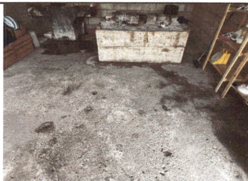
Foto: 6 Reparación de piso cerámico
