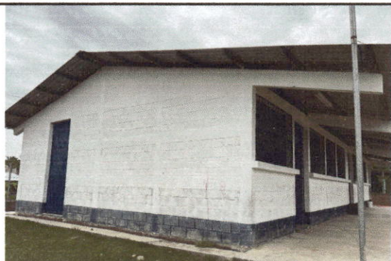
Foto: 5 Pintura en muros exteriores e interiores
