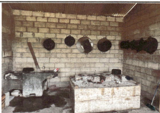
Foto 2: Repación de Cocina: Sustitución de estufa rural (completa) y Sustitución de pila de cemento de dos lavaderos.
