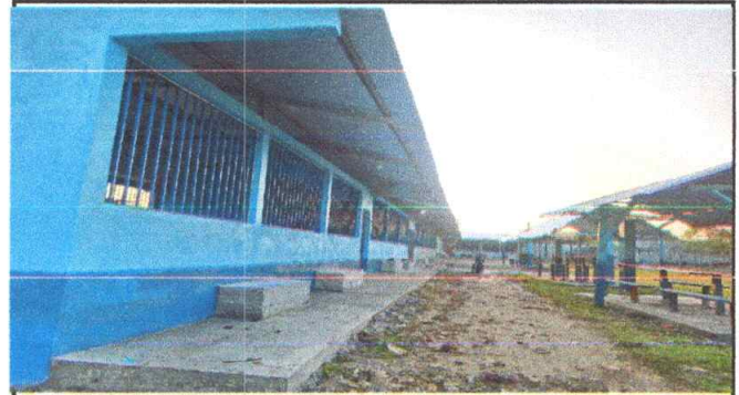
Foto 2: MANO DE OBRA ESPECIALIZADA
