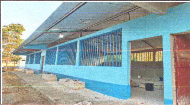
Foto 3: FABRICACIÓN E INSTALACIÓN DE BALCONES DE METAL
