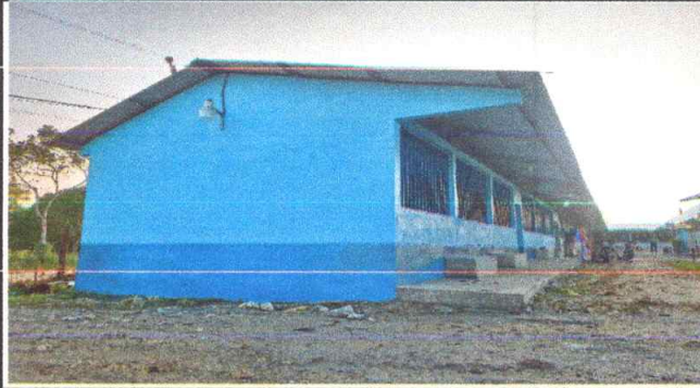
Foto 1: REPELLO EN MURO
