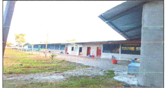
Foto 4: PINTURA EN MUROS EXTERIORES E INTERIORES
