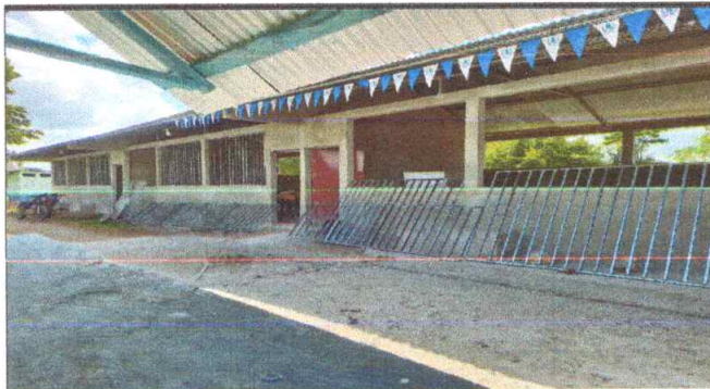
Foto 3: FABRICACIÓN E INSTALACIÓN DE BALCONES DE METAL
