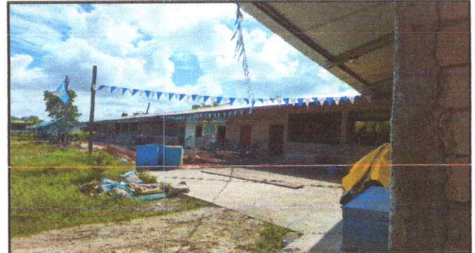
Foto 4: PINTURA EN MUROS EXTERIORNRES E INTERIORES
