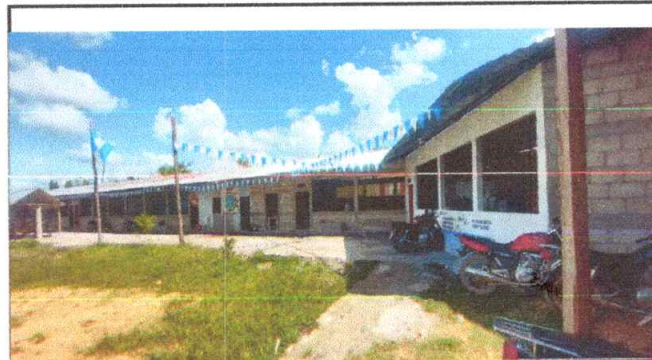
Foto 4: PINTURA EN MUROS EXTERIORES E INTERIORES
