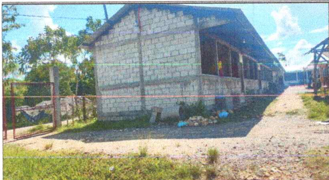
Foto 1: REPELLO EN MURO
