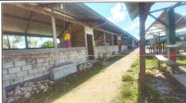
Foto 2: MANO DE OBRA ESPECIALIZADA
