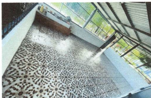
6.8. sustitución de piso de cerámica.
