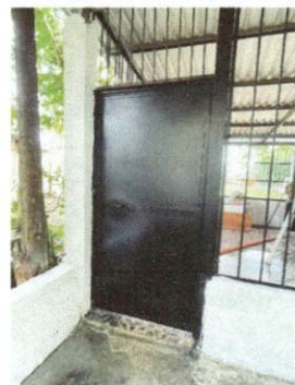
Foto 2: 4.3. Sustitución de puerta
