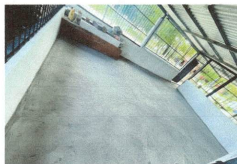
Foto 4: 6.5. Sustitución de piso de torta de concreto.
