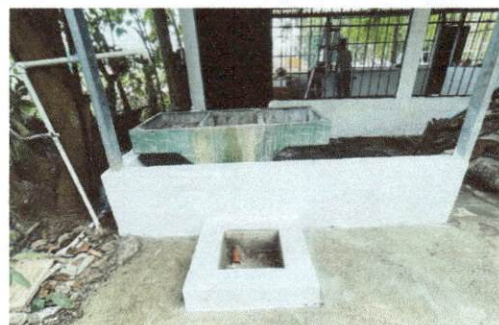
Foto 6: 14.8. Sustitución de caja de registro
