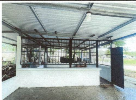
Foto 3: 5.6. Sustitución de balcones de metal
