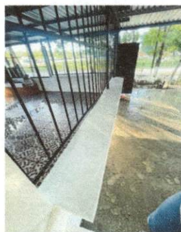
Foto 5: 8.2. Reparacion de banquetas de concreto
