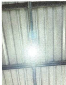
Foto 7: 17.8 sustitución de tomacorrientes, 17.11 Reparación de cableado eléctrico, 17.4 Sustitución de focos ahorradores, 17.5 sustitución de plafoneras, 17.10 sustitución de tablero de flípones, 17.90 sustitución de flípones, 17.60 sustitución de interruptores simples.
