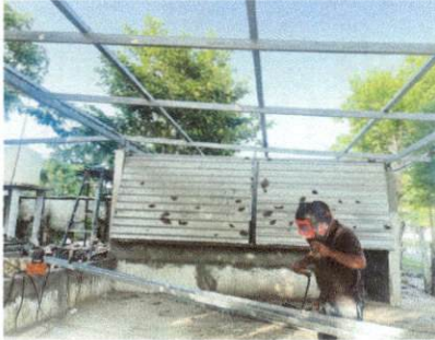
Foto1: 1.1. Sustitución de lamina, 1.3 sustitución de elementos de fijacion.
