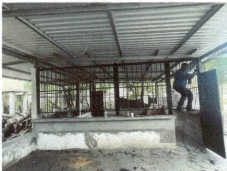
Foto 3: 5.6. Sustitución de balcones de metal
