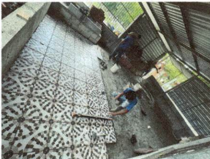
6.8. sustitución de piso de cerámica.
