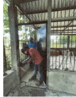
Foto 2: 4.3. Sustitución de puerta
