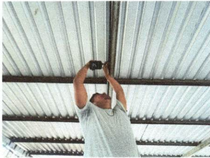
Foto 7: 17.8 sustitución de tomacorrientes, 17.11 Reparación de cableado eléctrico, 17.4 Sustitución de focos ahorradores, 17.5 sustitución de plafoneras, 17.10 sustitución de tablero de flipones, 17.90 sustitución de
