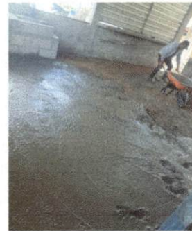
Foto 4: 6.5. Sustitución de piso de torta de concreto.
