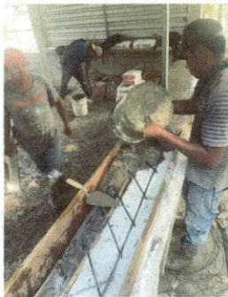
Foto 5: 8.2. Reparacion de banquetas de concreto
