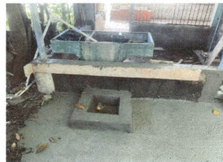
Foto 6: 14.8. Sustitución de caja de registro
