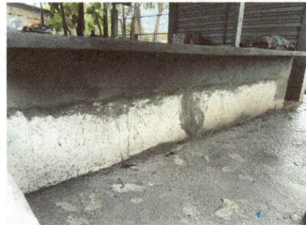
Foto 8: 21.1. Repello en muro, 21.4. Sellado de grietas y fisuras en muros.
