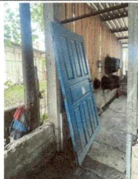
Foto 2: 4.3. Sustitución de puerta
