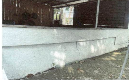
Foto 8: 21.1. Repello en muro, 21.4. Sellado de grietas y fisuras en muros.
