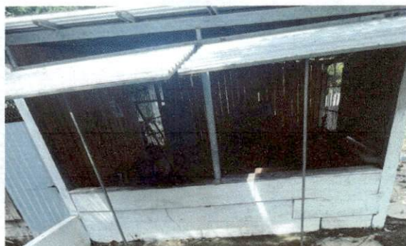
Foto 3: 5.6. Sustitución de balcones de metal
