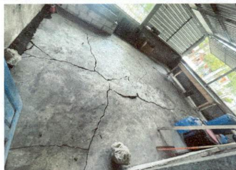
Foto 4: 6.5. Sustitución de piso de torta de concreto.
