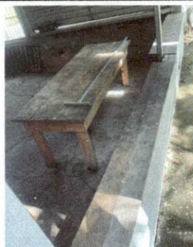
Foto 5: 8.2. Reparacion de banquetas de concreto
