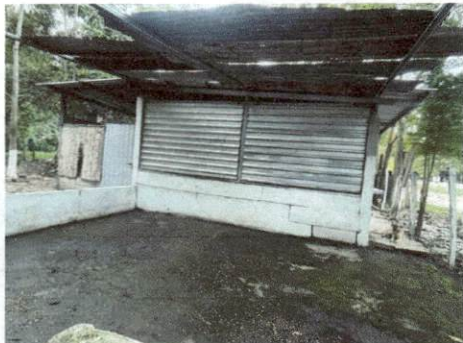
Foto1: 1.1. Sustitución de lamina, 1.3 sustitución de elementos de fijacion.
