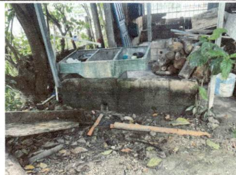
Foto 6: 14.8. Sustitución de caja de registro
