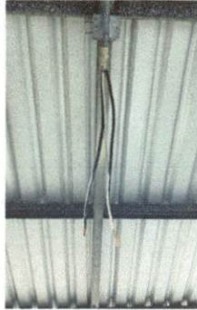
Foto 7: 17.8 sustitución de tomacorrientes, 17.11 Reparación de cableado eléctrico, 17.4 Sustitución de focos ahorradores, 17.5 sustitución de plafoneras, 17.10 sustitución de tablero de flipones, 17.90 sustitución de
