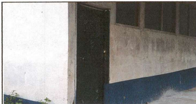
Foto 4: Sustrucción de puerta ✓
